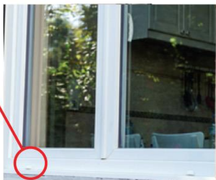
Ouvrant plat et drainage par busettes
